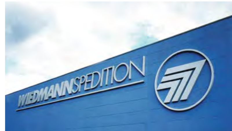
▲ Bau einer Lagerhalle mit Büros 1984/1985 – noch heute der Stammsitz.
