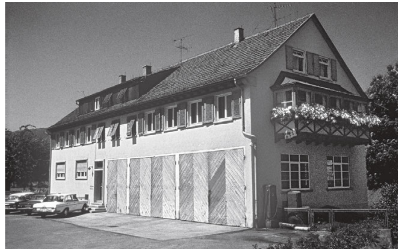
▲ Das Wohn- und Geschäftshaus in der Bad Überkinger Bahnhofstraße: Hugo Wiedmann errichtete es 1954 maßgeblich selbst.
