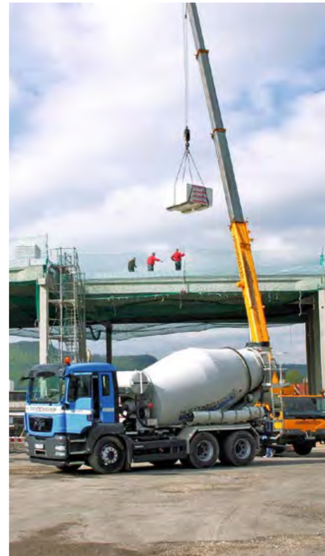
▲ 2013: Auf dem Gelände der alten Werkstatt entsteht eine neue Umschlagshalle.
